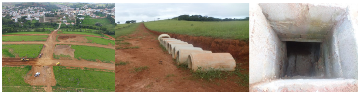
Figura 5 - Implantação de Sistema de esgotamento Sanitário e Drenagem Pluvial.
